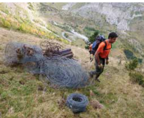
... enlèvement de clôture
