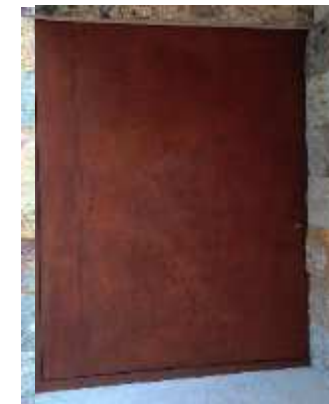
Fermetures : portes et contre-vents acier corten
