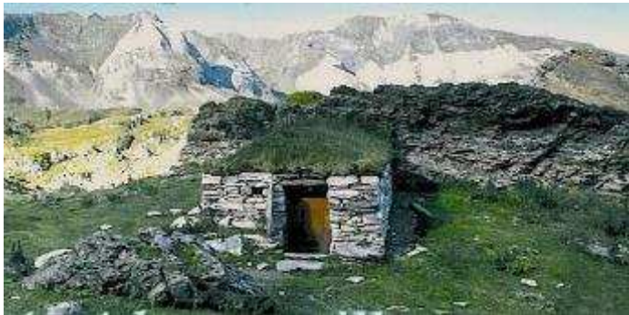
Toiture végétalisée et appareillage des murs
