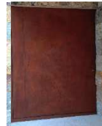
Fermetures : portes et contre-vents acier corten
