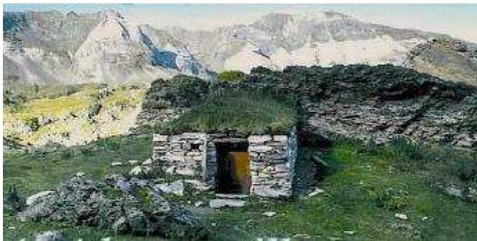
Toiture végétalisée et appareillage des murs
