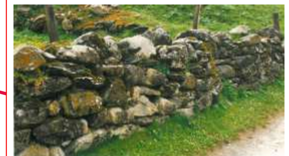
Muret irrégulier en pierre
