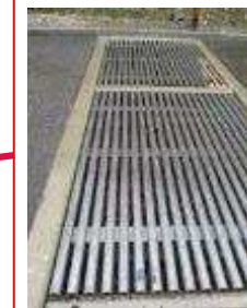
barrières canadiennes au départ du sentier et à l'entrée du Parking
