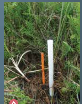
Un des 7 piézomètres (tube pvc perforé de trous laissant circuler l'eau) installés sur la tourbière qui permet de suivre les niveaux de la nappe souterraine.
