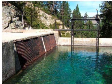
Les différents équipements présents sont : des prises d'eau réalisées sur le ruisseau d'Aygues Cluses (photo ci-contre), sur le ruisseau de la Glère et une retenue créée sur le lac Dets Coubous afin d'augmenter sa capacité. Une station de pompage en aval du lac de la Glère permet de remonter les eaux en direction de la centrale de Pragnères ou du lac Cap de Long, ce dernier ayant la capacité de stockage principale du dispositif.
