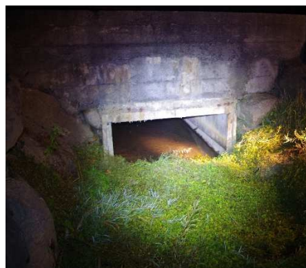
Figure 22 : Pont cadre sous la route de Gez
