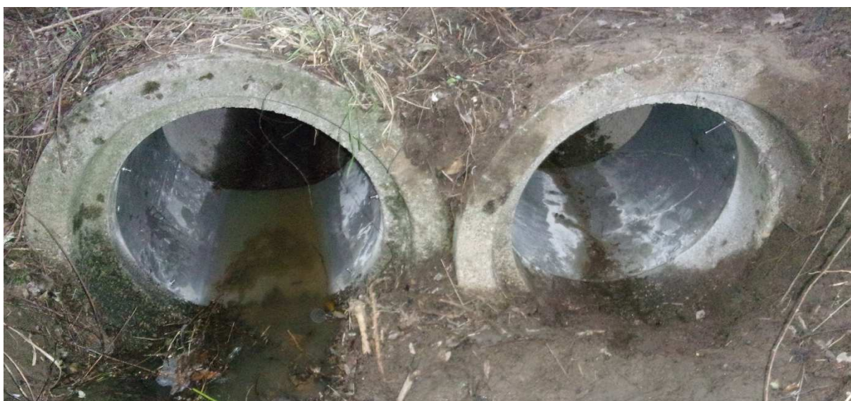
Figure 27 : pose en interne dans des tuyaux ciment
