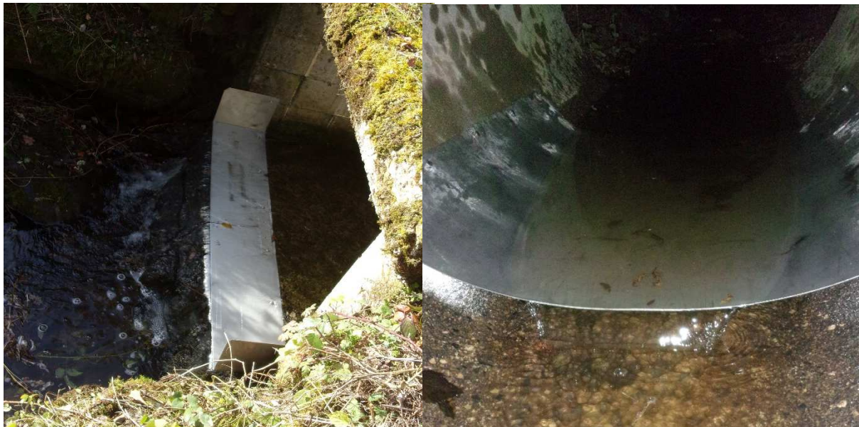
Figure 27 : pose en débord à l'aval de l'ouvrage
