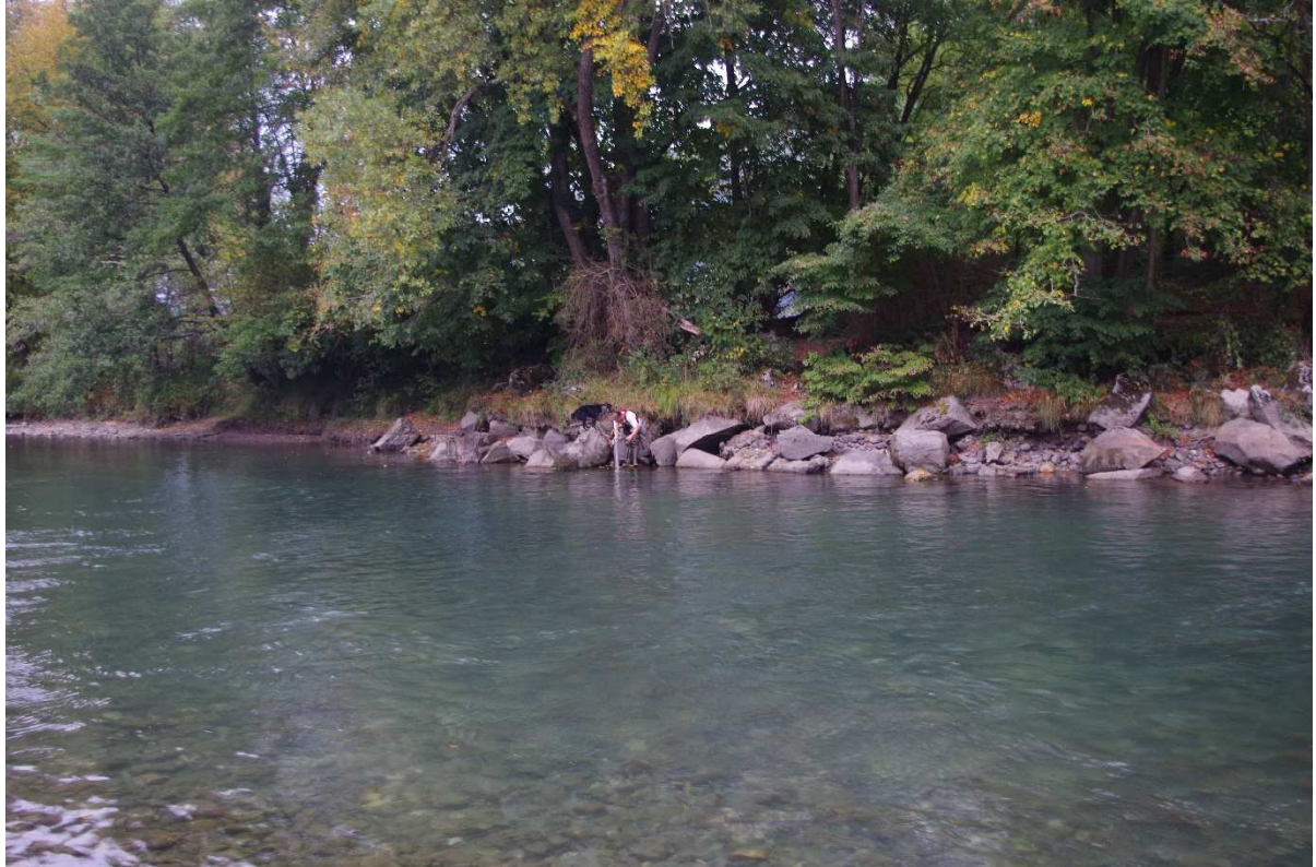
Figure 20 : prospection à l'aquascope dans les enrochements sur le Gave de Pau
