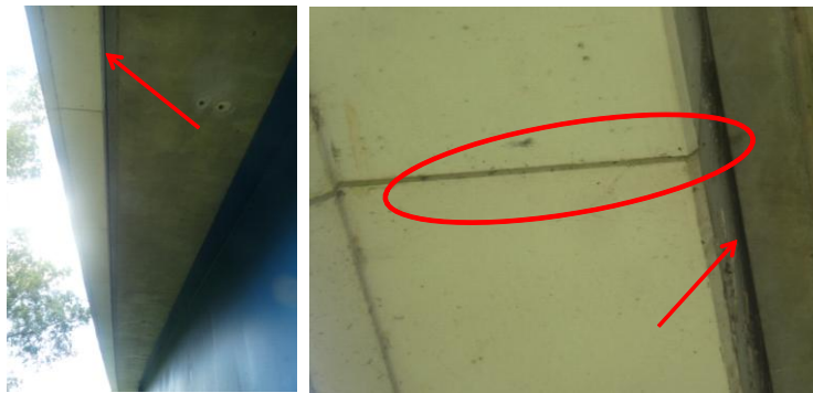
Espace dans la corniche, vu de dessous -- guano visible sur le rebord à l'aplomb de la corniche
