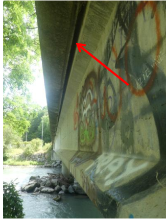
Interstice dans la corniche, vu de dessous -- guano visible sur le rebord à l'aplomb de la corniche
