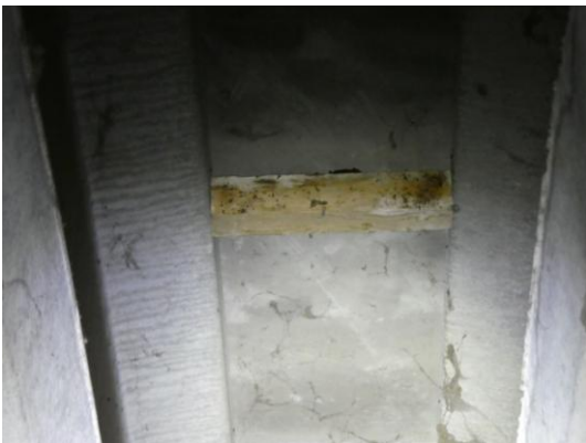
Planchette sous le tablier, entre deux poutres – Pont n°39
