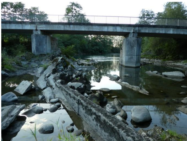
Pont des grottes à Saint-Pé de Bigorre, abritant des chauves-souris
