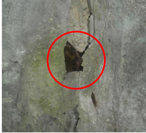
Espaces entre les dalles et illustration d'un des trois trous de barre à mine
