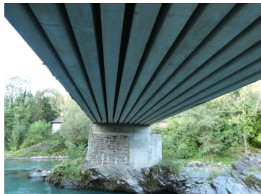
Espaces entre-poutres sous le tablier – Pont des grottes (n°1)
