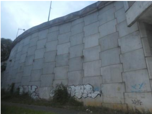
Prolongement mural de la culée – Pont de Lourdes = Viaduc (n°31)
