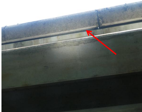
Interstice dans la corniche, vu de dessous -- guano visible sur le rebord à l'aplomb de la corniche
