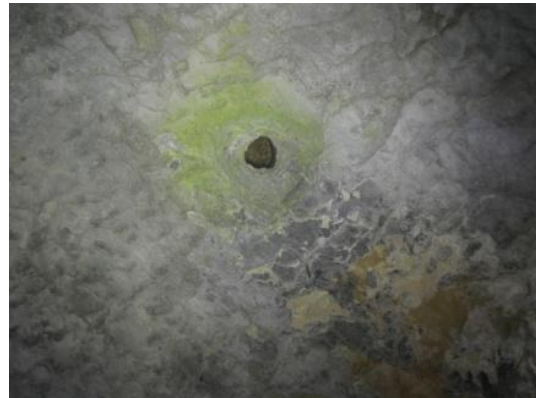
Trou de barre à mine – Pont n°15
