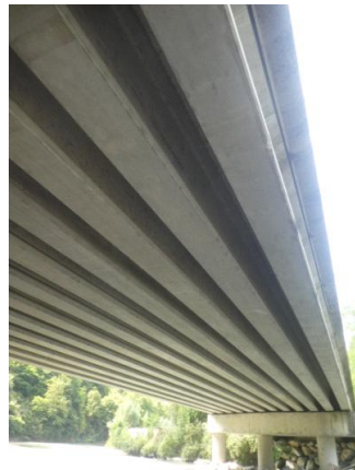
Espaces entre-poutres sous le tablier -- exemple d'une zone utilisée par les chauves-souris, avec guano sur le rebord
