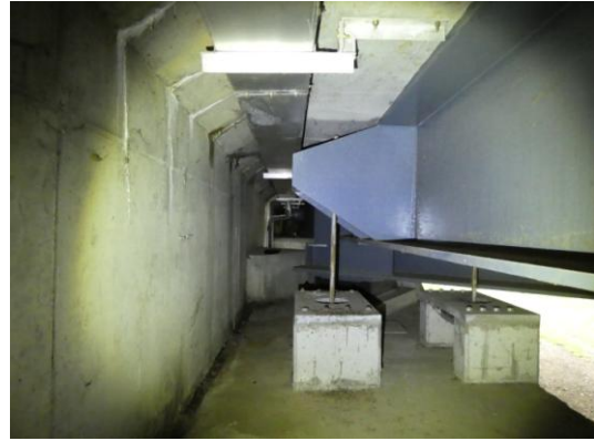
Espaces dans la culée – Pont de Buala (n°33)
