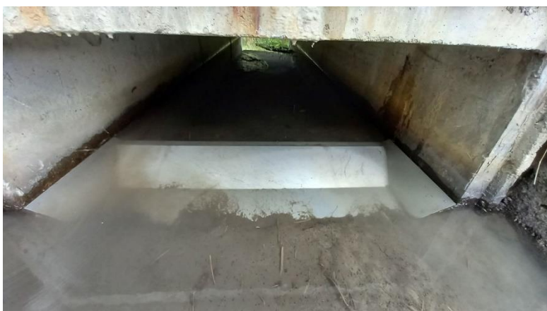
Figure 18 : Seuil installé sur le Bayet à Gez © PLVG
