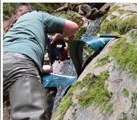
**Figure 25 : Illustrations du dispositif anti-remontée d'écrevisses sur l'Ouzous**
