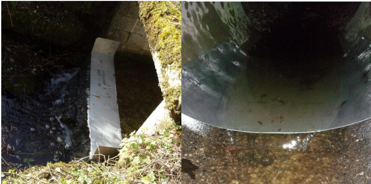
Figure 17 : pose en débord à l'aval de Figure 17 : pose en interne, vue de l'aval l'ouvrage
