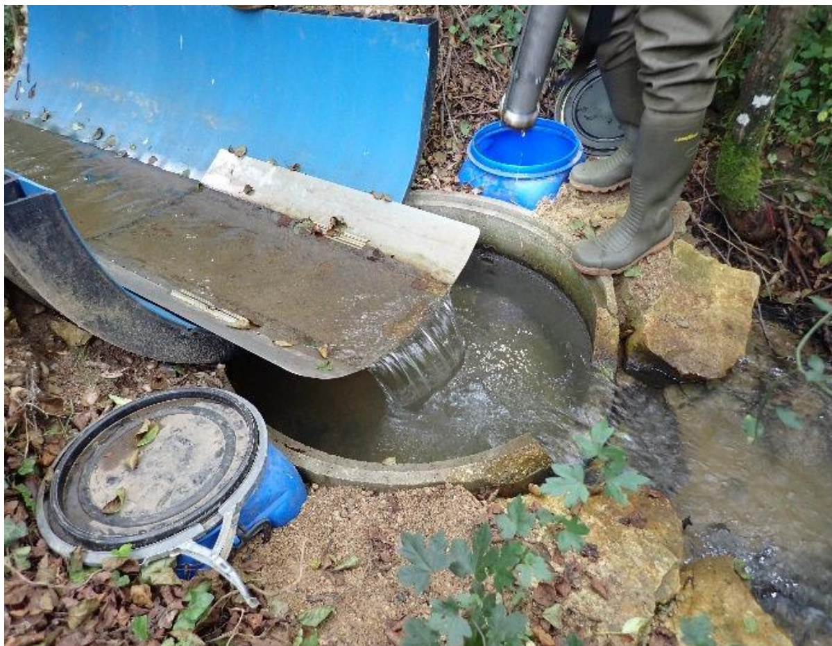
Figure 15 : fosse piège installée dans le Lot
