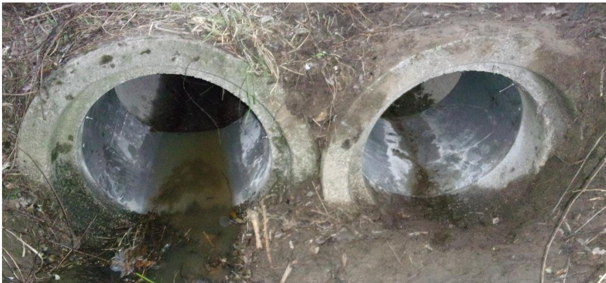
Figure 19 : pose en interne dans des tuyaux ciment
