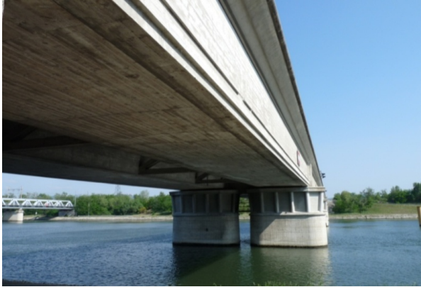
photo 3 : Ouvrage d'art à tablier creux © Julien GIRARD-CLAUDON
