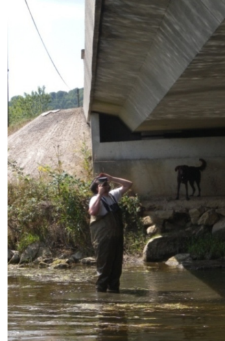
photo 4 : Inspection d'une corniche © Julien CORNUT
