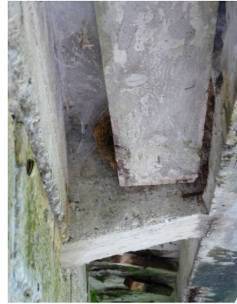
photo 22 : Nid de troglodyte sur une ancienne planche de coffrage © Julien GIRARD-CLAUDON
