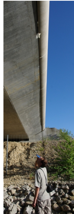
Photo 10 : Inspection des corniches d'un pont TGV © Julien CORNUT
