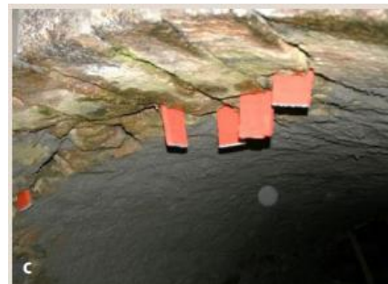
Photo 19 : Cavité bouchée à l'aide de gaine d'isolation de tuyau de chauffage (Source : S. Bareille)
