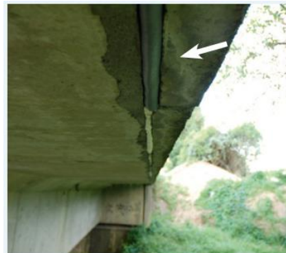
Photo 19 : Cavité bouchée à l'aide de gaine d'isolation de tuyau de chauffage (Source : S. Bareille)
