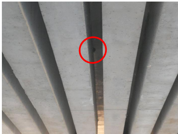
Espaces entre-poutres sous le tablier ; l'un d'eux abrite une chauve-souris
