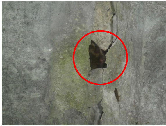
Murin cryptique installé dans l'interstice entre deux dalles de pierre
