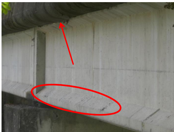
Interstice dans la corniche, vu de dessous -- guano visible sur le rebord à l'aplomb de la corniche
