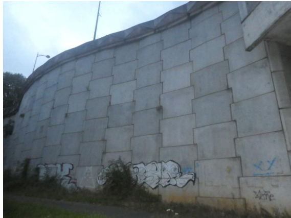
Prolongement mural de la culée côté aval RD, les interstices entre dalles abritent des chauves-souris
