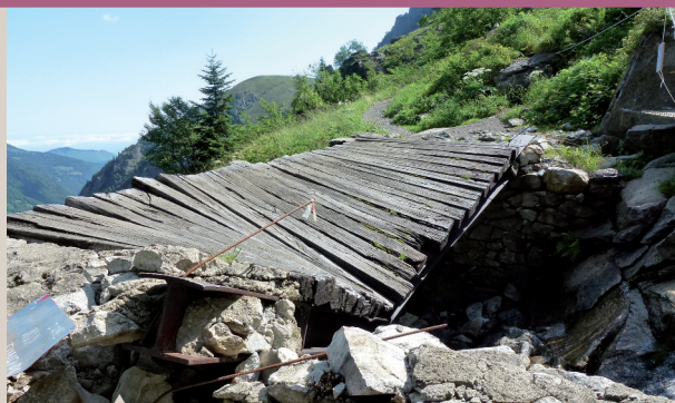
L'un des ponts permettant l'accès au Lac Bleu a été extrêmement endommagé par les intempéries hivernales. (photo A. CIPHERE, GIP-CRPGE)
